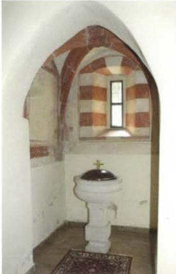
*Taufkapelle mit Kreuzrippengewölbe, an der Wand anlaufende Rippen mit Birnstabprofil, rosettenförmiger Schlussstein, Beginn 14.Jhdt.*
